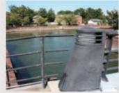
住吉入江にかかる、暴風時などの船舶を避難させるための昇開橋。高欄支柱が鑄物製。
